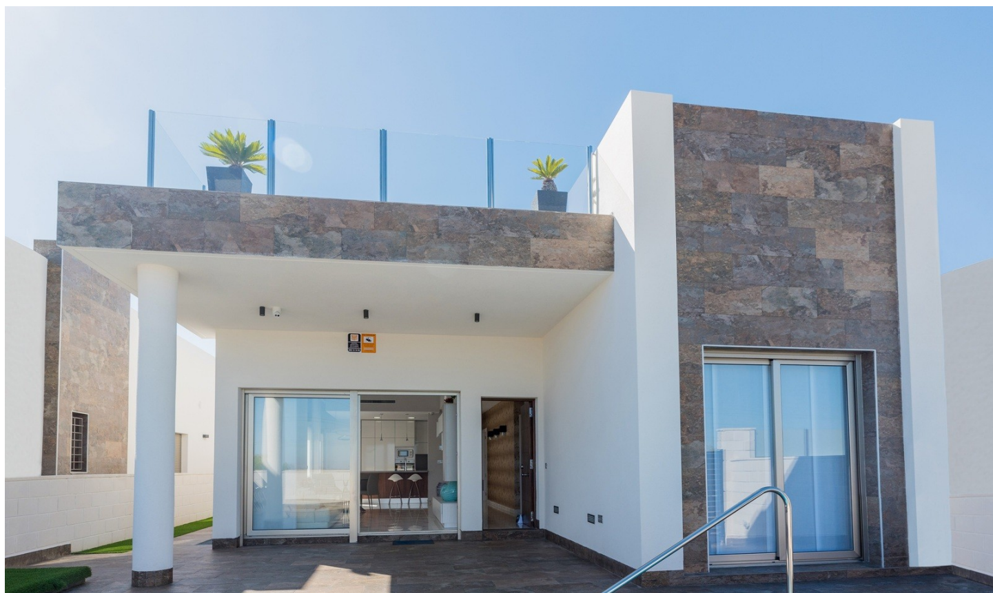
03189 Villamartin | Costa Blanca South | Project | Référence: CBLS2222-14896
