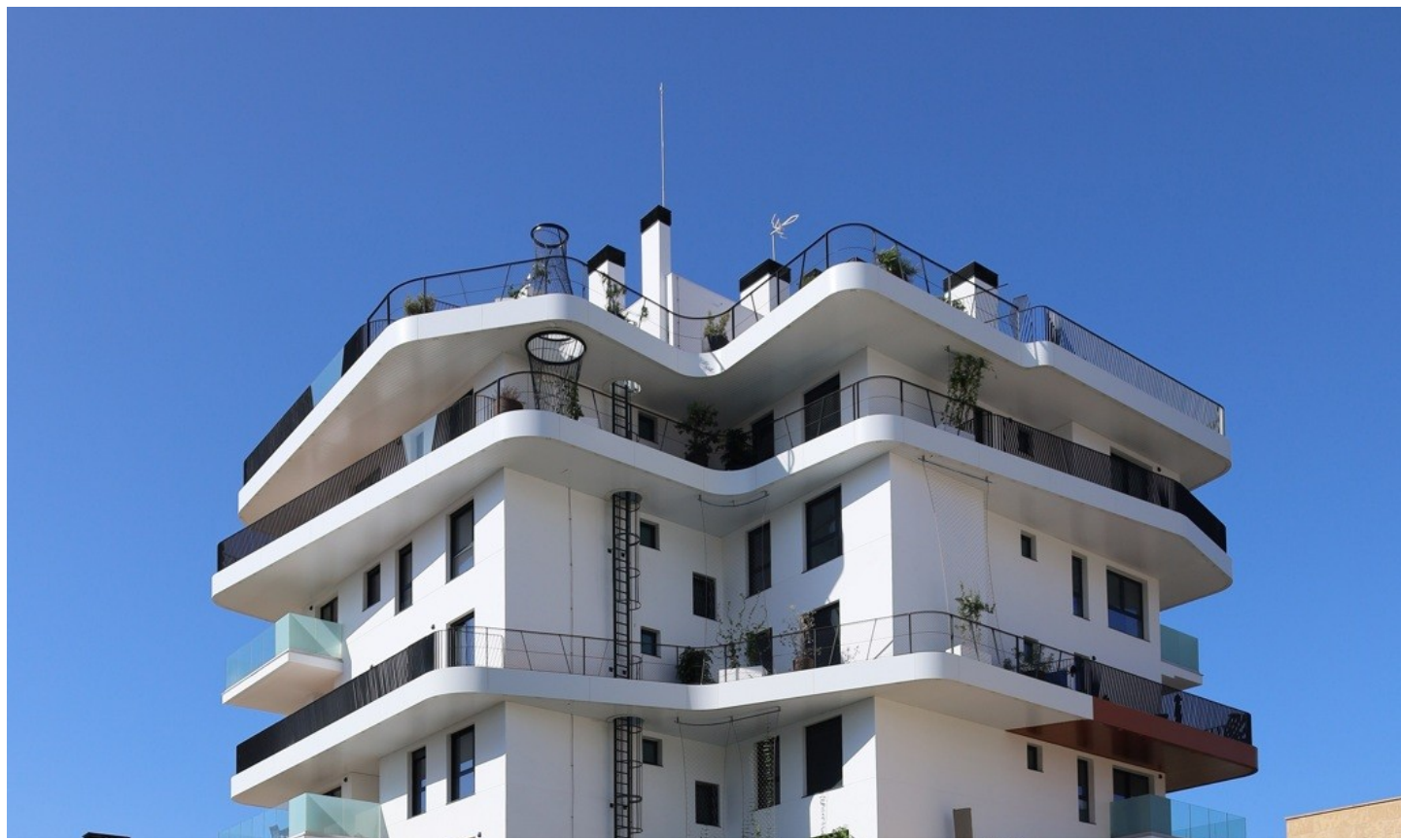
03570 Villajoyosa | Costa Blanca North | Project | Référence: CBLN8621-15179
