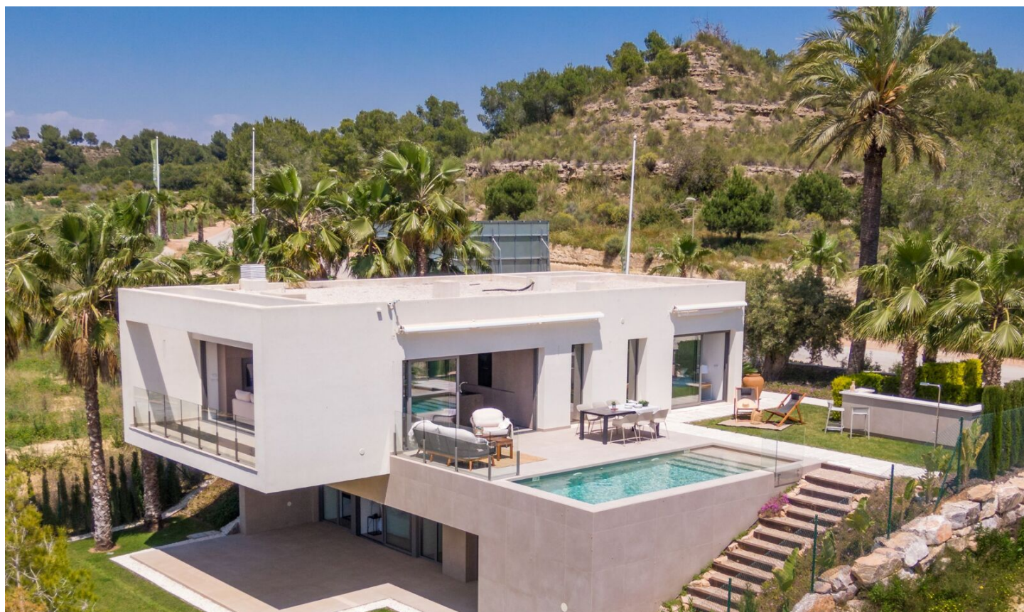
03189 Las Colinas | Costa Blanca South | Project | Referentie: CBLS10435-15070
